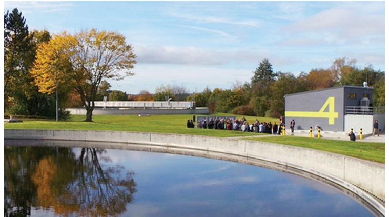
Abb. 1 Kläranlage mit vierter Reinigungsstufe
