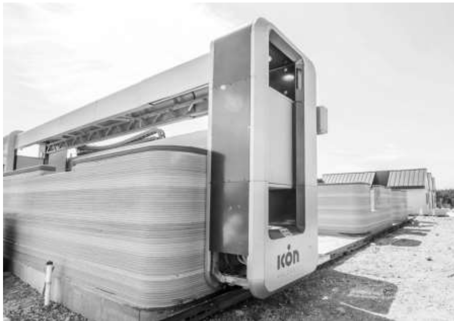
Abb. 4.3 3-D-Maschine: Manipulator und Druckkopf
